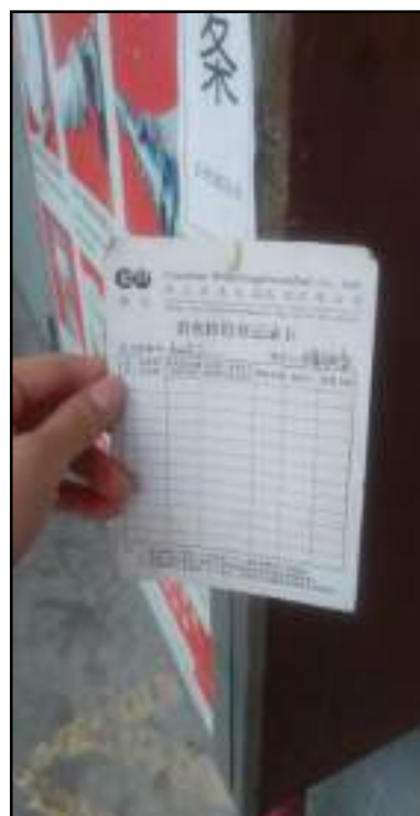
按照记录，消防设备未经检查
