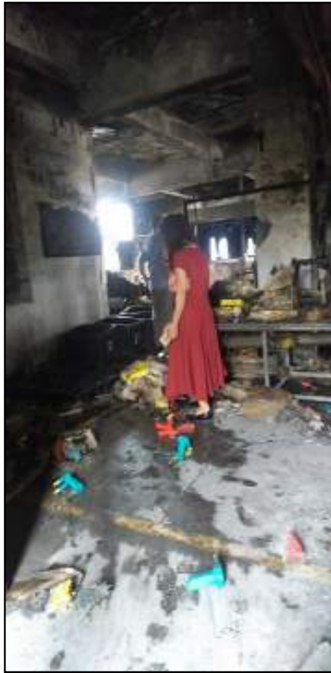
管理在检查火灾车间
